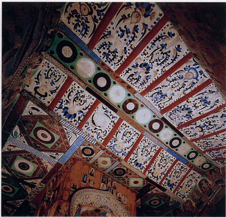
图3 甘肃敦煌莫高窟第288窟窟内人字坡顶椽子望板彩绘(西魏)(引自《敦煌石窟全集·石窟建筑卷》)
