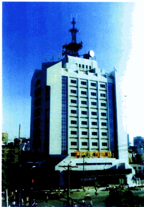
电信枢纽大楼
