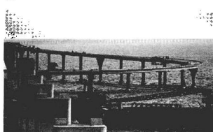
图 00-04 上图为上海东海大桥，中国首座外海跨海大桥，2005 年 11 月 17 日建成通车，全长 32.5 公里。下图为杭州湾跨海大桥。
