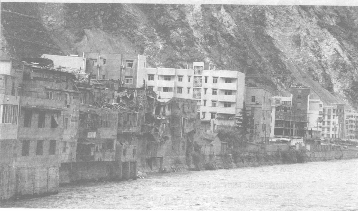
地震过后，汶川县城到处是这种危楼。而距离它们几十米远处，就是随时可能滑坡的山体。（2008年6月16日10时54分作者摄于汶川县城）
