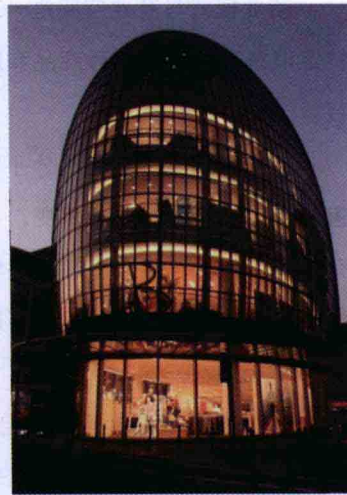
图1-3 位于德国科隆市中心的皮克-克洛彭堡的新型百货商店（Peek & Cloppenburg Department Store）。这是一幢由钢框架和玻璃幕墙构建而成的商业大厦，极具现代高技派建筑风格
