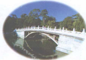
stone arch bridge 石拱桥
