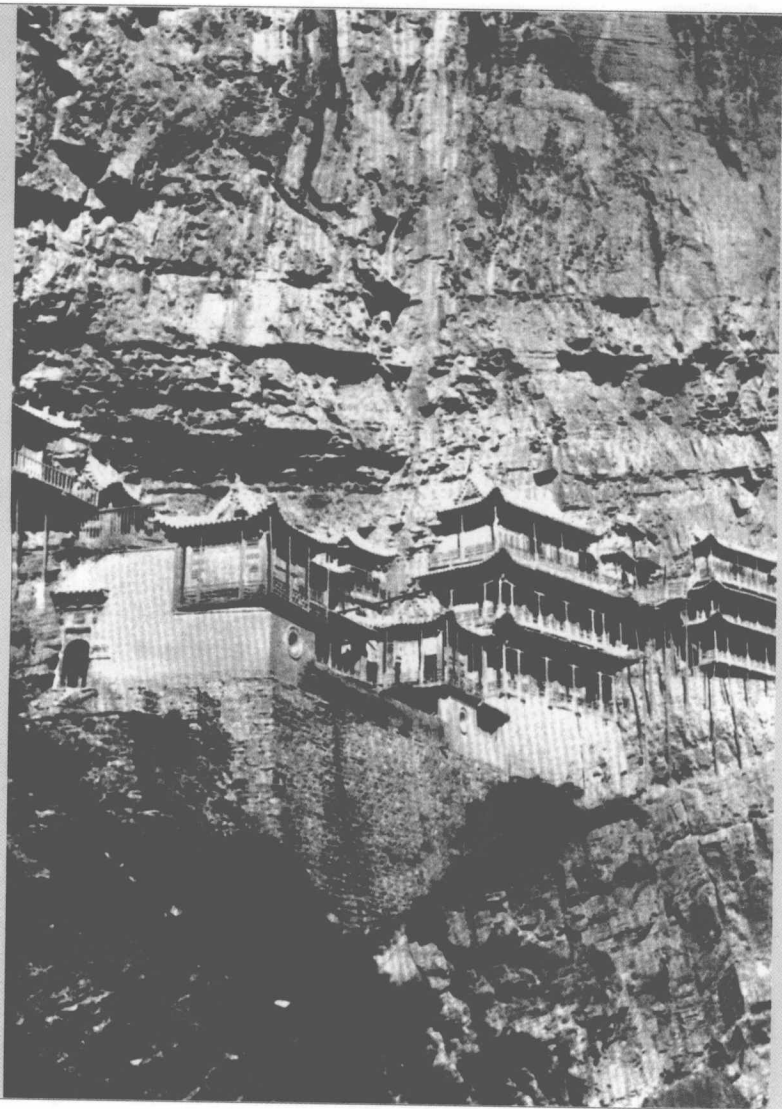
图为恒山悬空寺。寺庙全身悬挂于石崖中间。表面上看，整个建筑的支撑是十几根碗口粗的木柱，其实真正的重心撑在坚硬岩石里。
