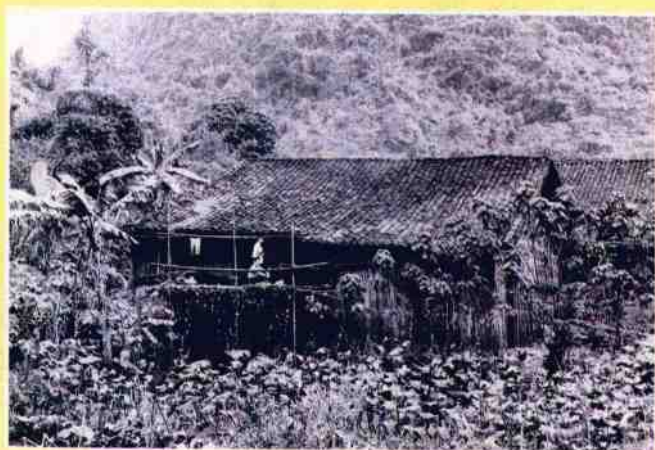
▲那坡县人民政府成立(1949年11月)旧址——云南省富宁县田蓬镇上坞村坡林屯。
