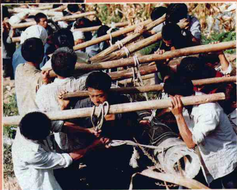
▲ 为实现电气化,边民齐心协力抬水泥电杆上山。
