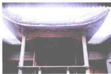
上山坑祠堂戏台
