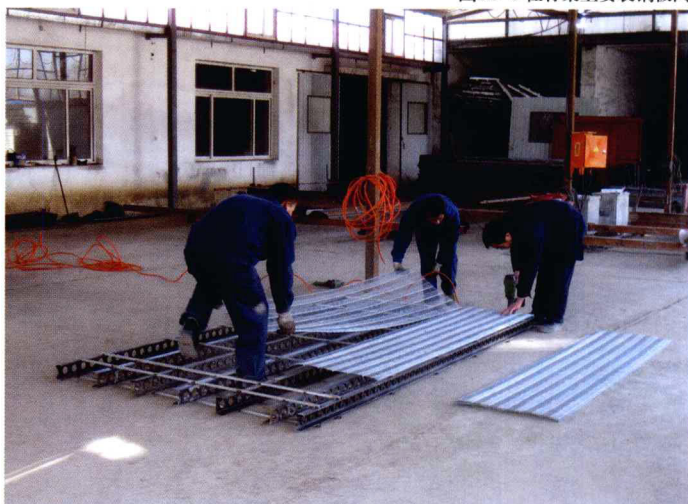
图1.3-8 在骨架上安装钢板网
