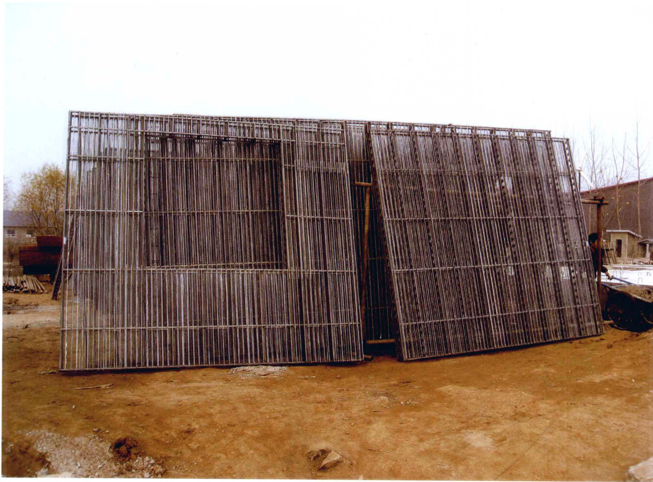
图1.3-12 钢网构架堆放
