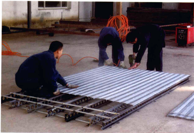
图1.3-9 用射钉枪固定钢板网
