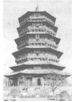
图 1.4 山西应县木塔
