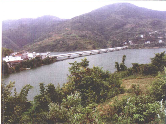
隆林最长最大的桥梁 ——那芝大桥
