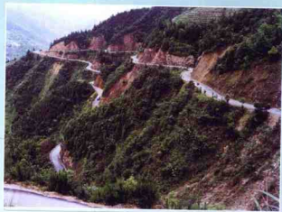
龙脊公路, 1999年12月动工改造, 2001年6月竣工 (袁代江 摄)
