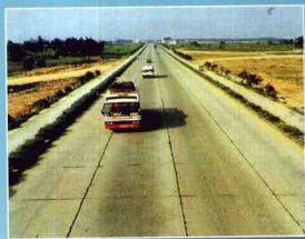
广西第一条一级公路——桂(林)灵(川)公路, 1988年9月动工, 1990年10月竣工
