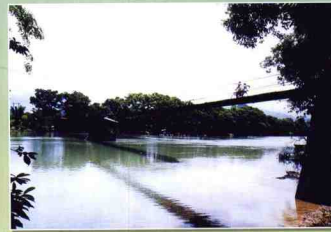
恭城县林家砦铁索桥（莫迪生 摄）
