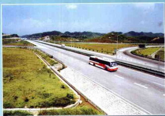
桂林两江国际机场路, 1993年7月动工, 1996年8月竣工 (莫迪生 摄)
