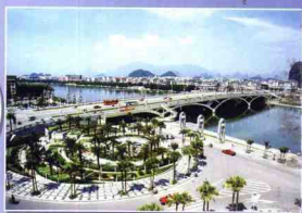
桂林新解放桥，1999年10月动工，桥长284米，5孔，桥宽45米。2001年9月竣工（莫迪生 摄）
