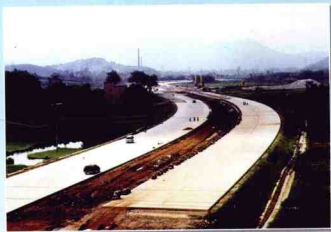
正在建设中的广西第一条一级旅游专用公路——桂(林)磨(盘山)公路, 2000年12月开工 (莫迪生 摄)
