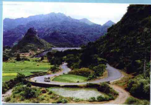
安(和)蕉(江)公路磨盘水库段, 1997年动工, 1998年竣工 (莫迪生 摄)
