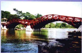
桂林西清桥，桥型仿伦敦剑河上的“数学桥”建筑而成。2002年拆除旧桥重建，新桥长48.8米，宽4.5米，桥身用名贵红松木装饰（周文宗 摄）
