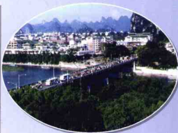
桂林旧解放桥，1951年在原中正桥原址建设，1972年改建，1999年12月拆毁
