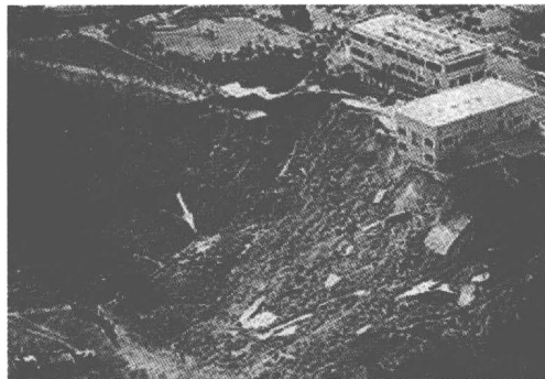
图 1-9 土体滑坡 the Vaiont Dam (1963) Italy
