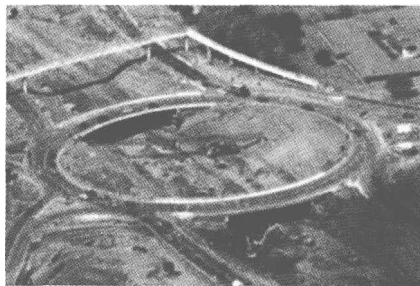
图 1-7 城市环形高架道路
