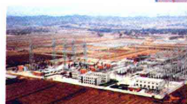
晋东南变电站
