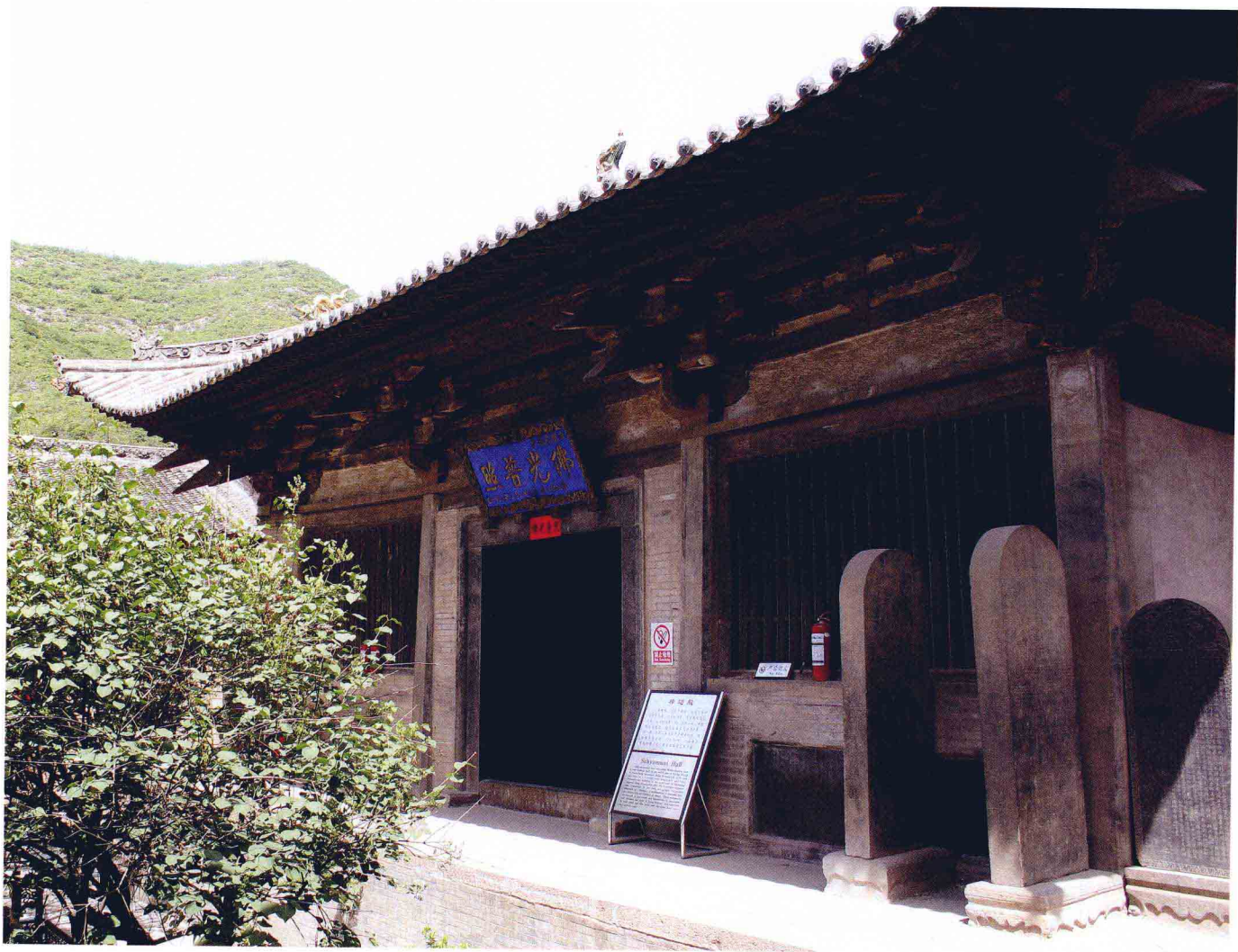
图21 山西晋城市释迦殿直棂窗
