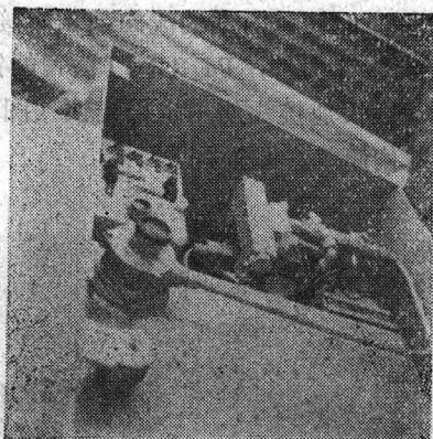
图22 油压调速装置
