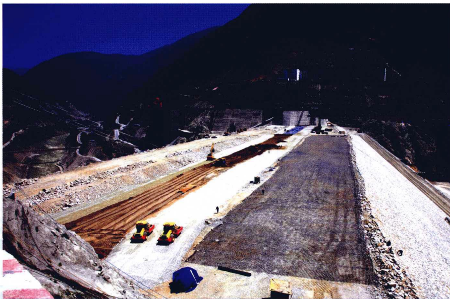
大坝填筑（梁江 摄）
