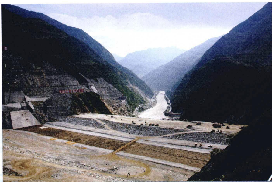
大坝下游填筑面貌（梁江 摄）
