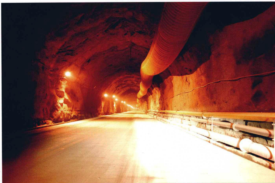
地下主厂房施工支洞（刘飞 摄）
