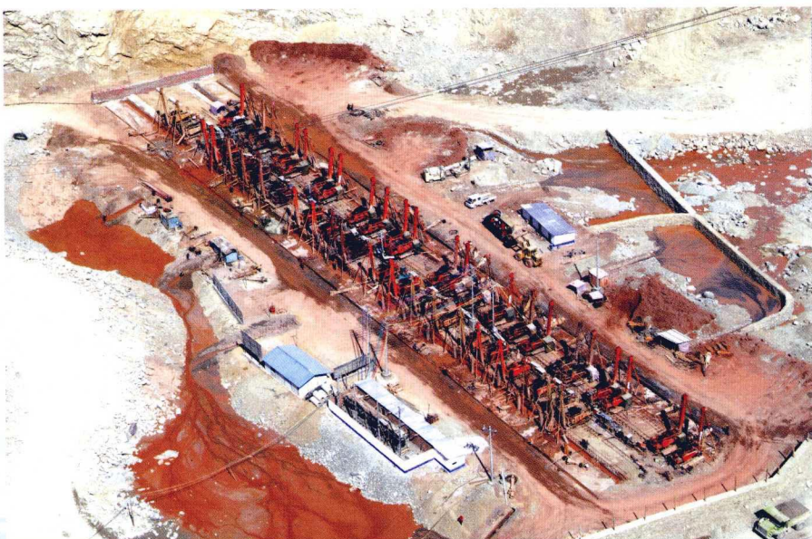
大坝防渗墙施工（梁江 摄）
