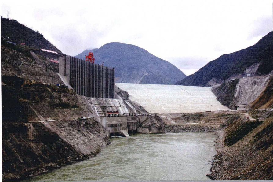
大坝填筑完成后上游面貌（梁江 摄）
