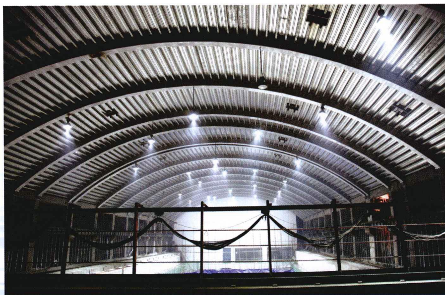
厂房吊顶（梁江 摄）
