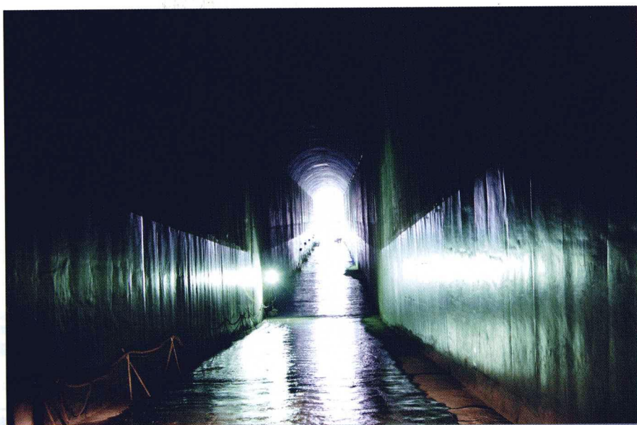
放空洞 (梁江 摄)
