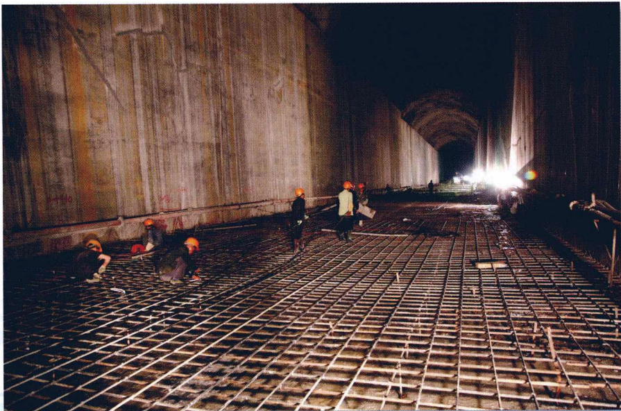
泄洪洞施工（梁江 摄）
