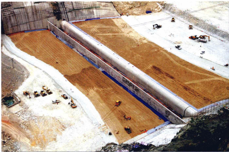
大坝心墙廊道（梁江 摄）
