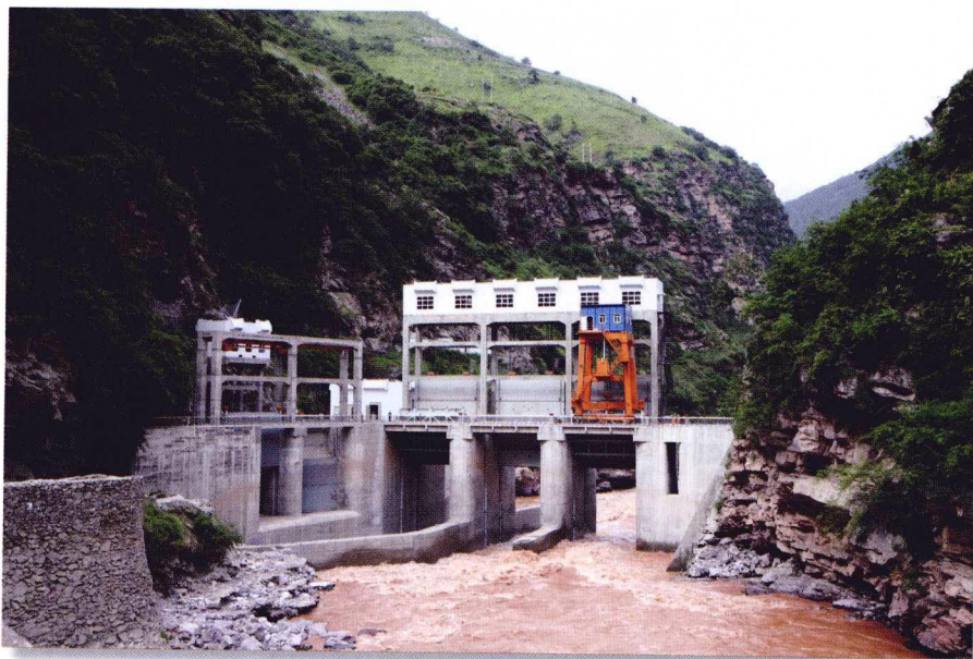
尼日河闸首 (梁江 摄)
