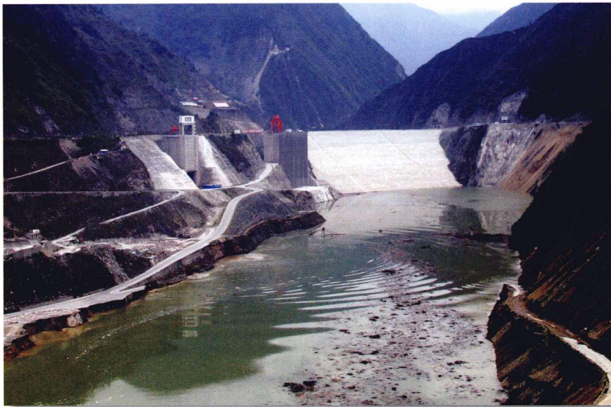
2号导流洞下闸蓄水 (梁江 摄)
