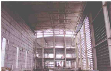
图 1-13 阀门墙面龙骨的安装
