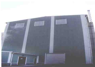
图 1-14 阀厅墙面彩钢示例
