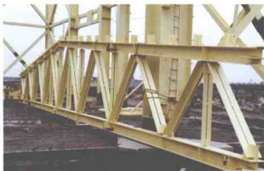
图 1-5 阀门钢屋架的地面组装
