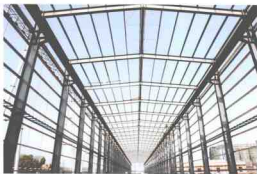
图 1-8 阀厅钢结构示例
