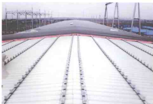
图 1-11 屋面板的安装
