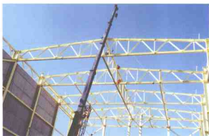
图 1-6 阀门钢屋架吊装
