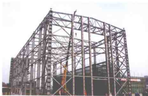
图 1-4 阀门钢柱的安装
