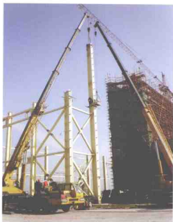
图 1-3 钢柱的吊装
