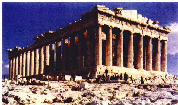
图7 希腊雅典卫城中的帕提依神庙,柱廊式建筑整体均由大理石构成。
