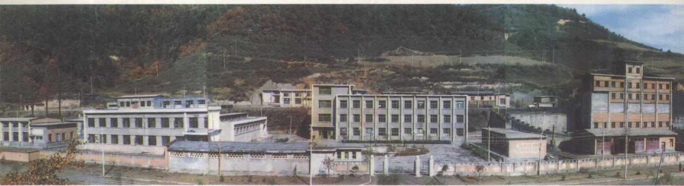
延安车村煤矿鸟瞰图 李定国 摄
