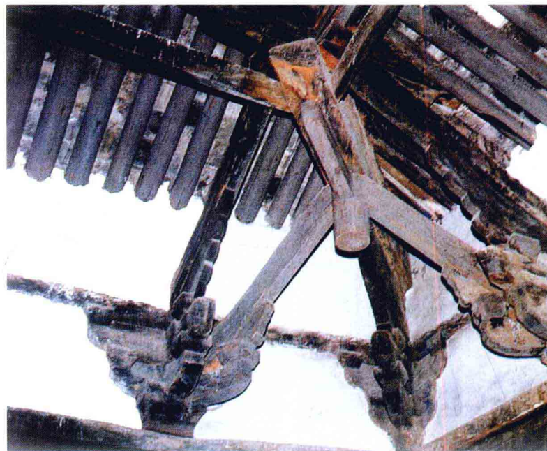
2. 中佛殿转角铺作内转构造
