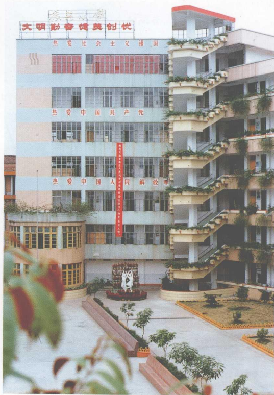
振兴小学教学楼
