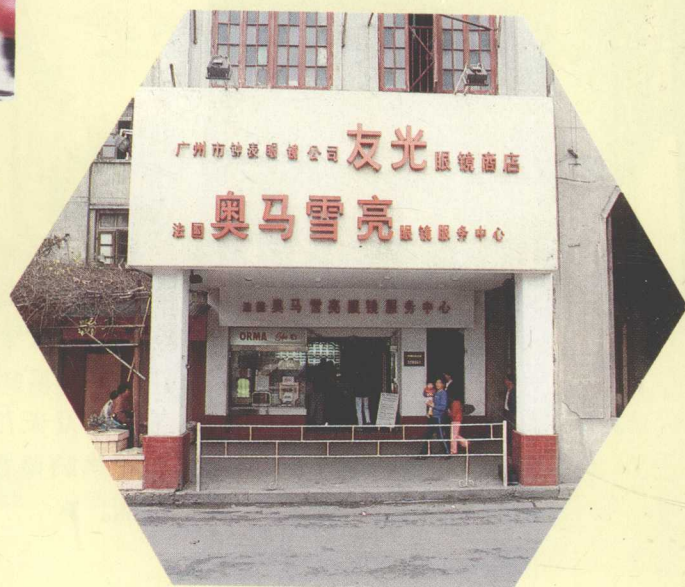
▼商店騎樓內外門面，人行道上天花，都採用白色噴塗，裝飾格調統一。
