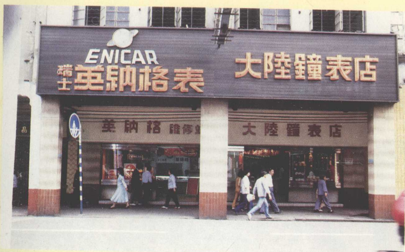
▲騎樓裙上古銅鋁合金扣板招牌，牆柱貼錦磚，騎樓下招牌噴塗，門口設有通透櫥窗。
