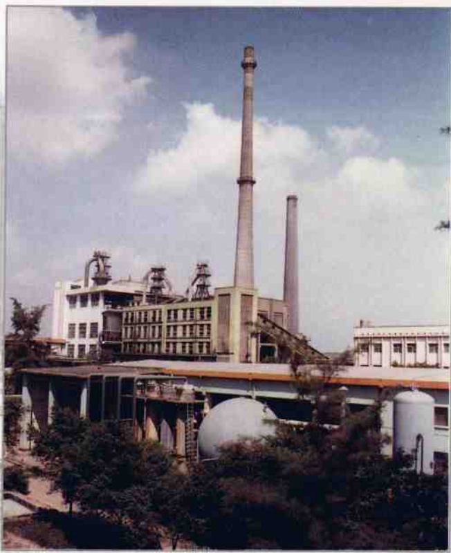
该公司动力厂主厂房
