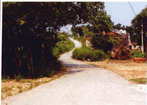
捐款修建的寿山村村级公路
