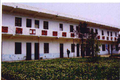
陈巷福利院宿舍楼
