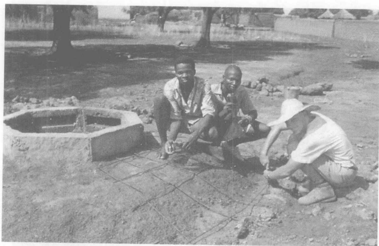
约翰带着学徒重建生产之屋的水井
