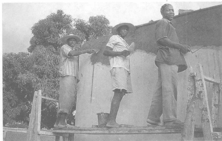
泥水匠正为生产之屋涂上外层水泥
