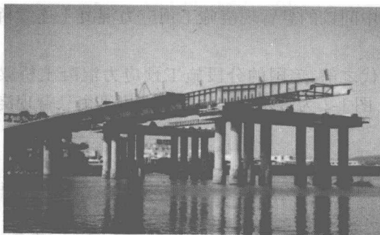
图 1-4 利用预应力技术进行连续梁桥的顶推施工
