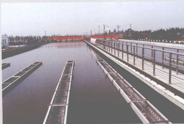
▲ 高新区水力枢纽工程
