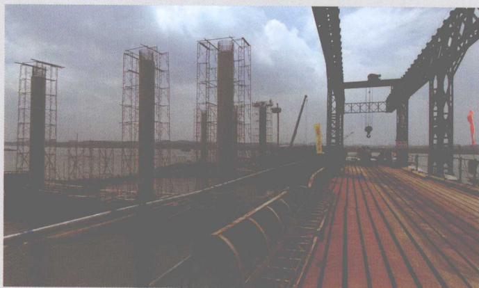
新建的二广高速公路 ▶
