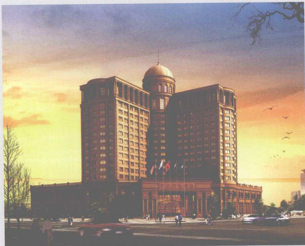
◀ 正在兴建的高新区五星级酒店
