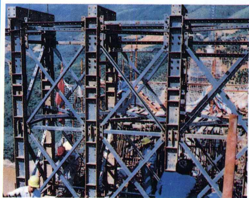
▲ 安装V撑中心平衡塔
