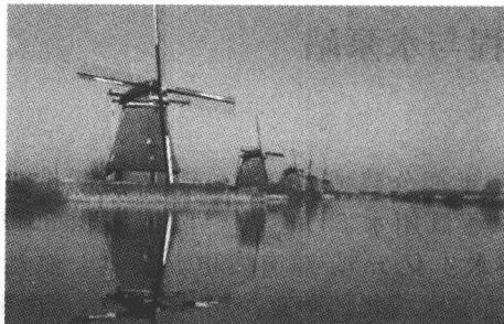
境内河流纵横，一半以上的国土在海平面以下。为避免海水涨潮淹没土地，早在13世纪就筑堤坝拦海水，再用风动水车抽干围堰内的水，现在水泵早已取代水车。荷兰围海造田几百年，修筑的拦海堤坝长达1800km，增加土地面积60多万亩 $hm^2$ ，为国土的20%。
