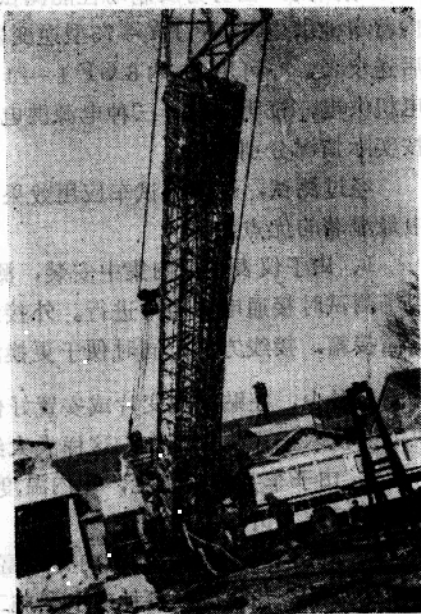
图5—1 塔机测试现场
