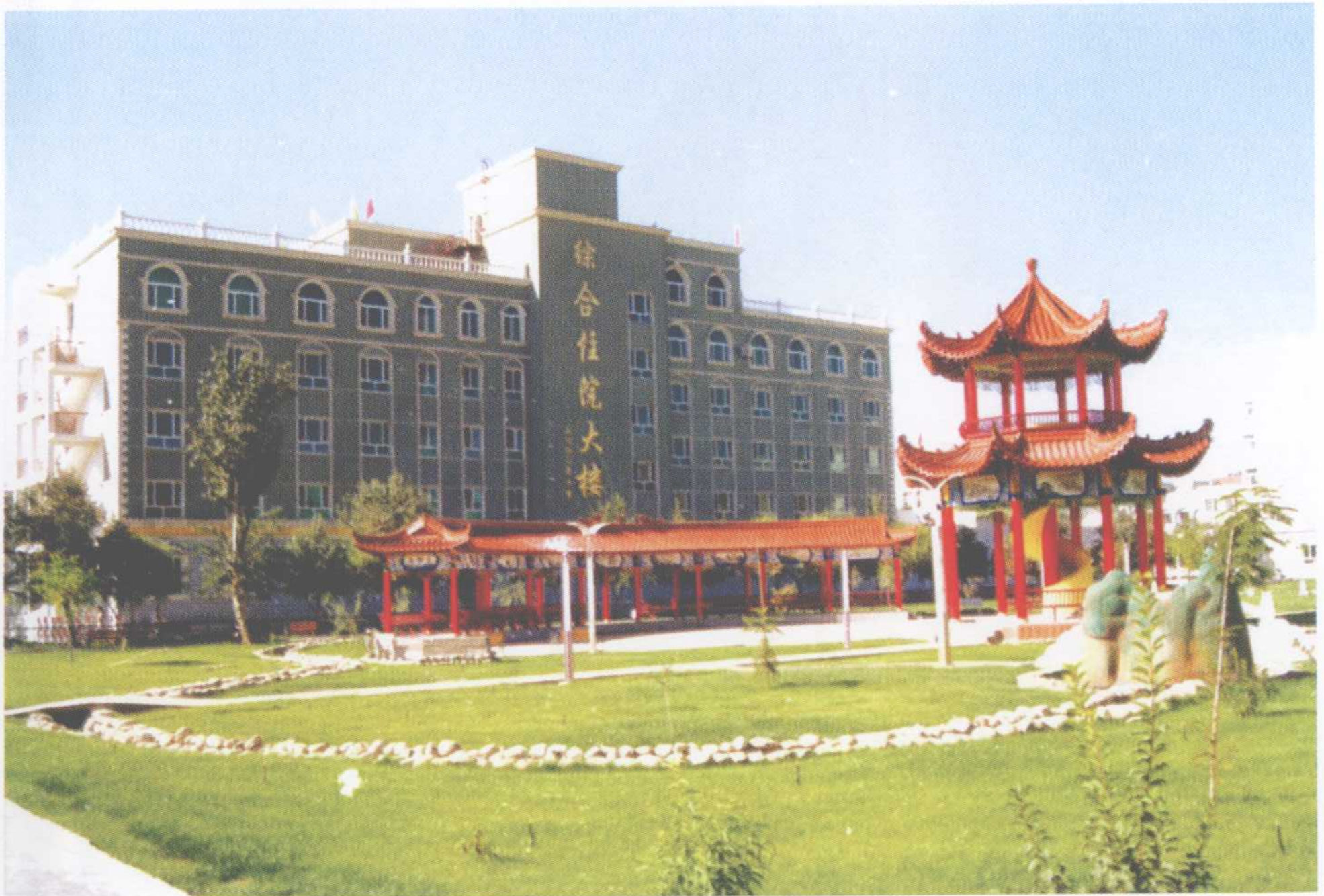
焉耆县人民医院综合住院大楼
