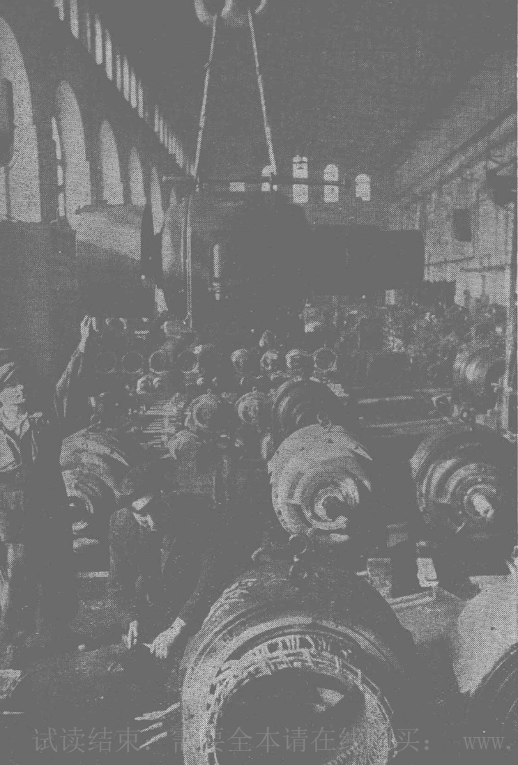
在第五個五年計劃中，愛沙尼亞將興建納爾夫水力發電站。圖為「伏特」 電力機械製造廠的車間，正在製造電力機械支援發電站建設工程。
