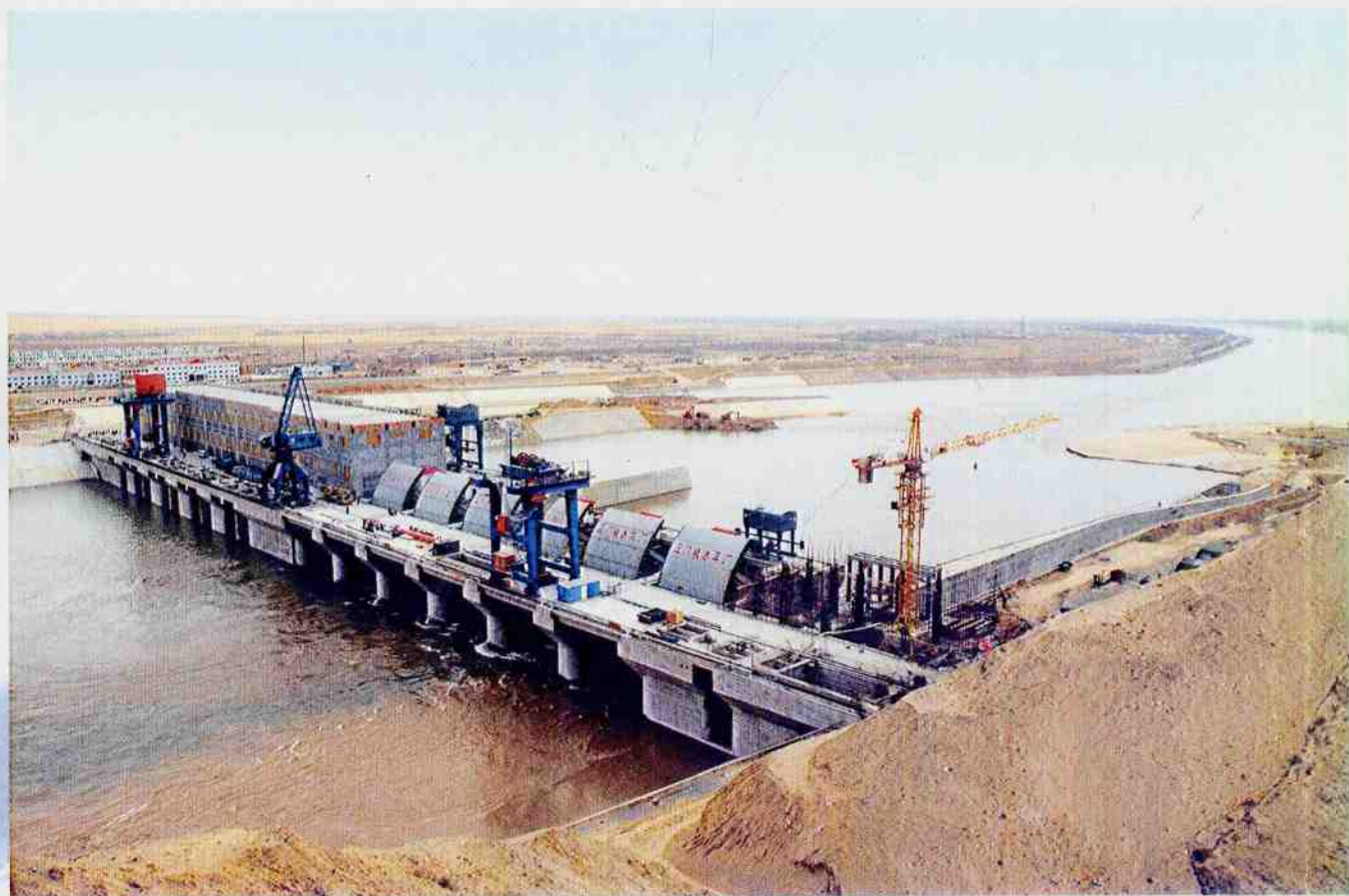
沙坡头水利枢纽
