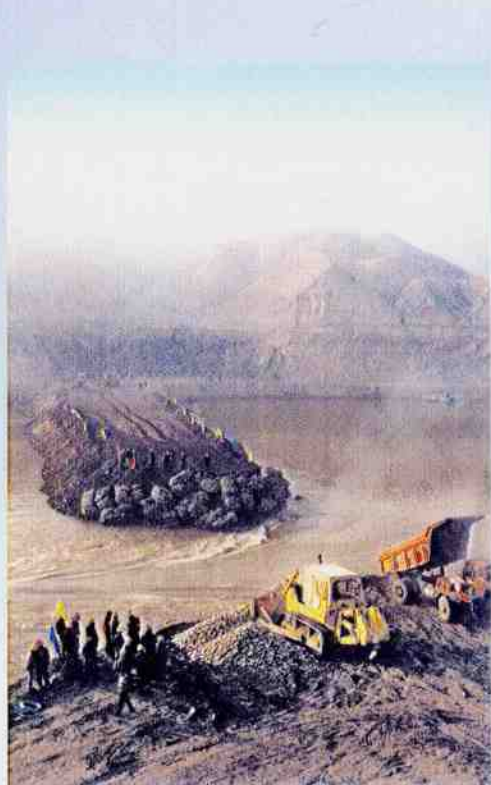
沙坡头枢纽截流
