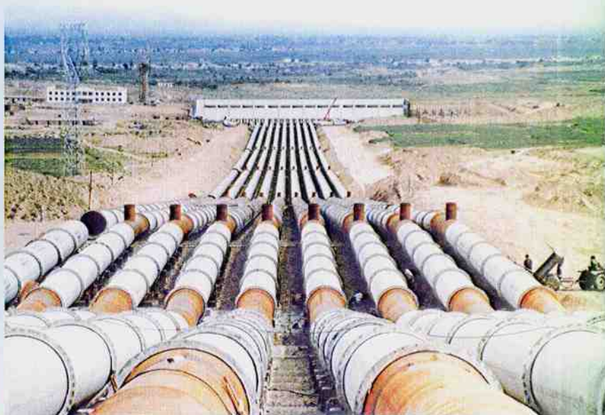
扶贫扬黄工程红寺堡一泵站
