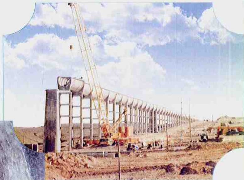
固海扩灌渡槽吊装
