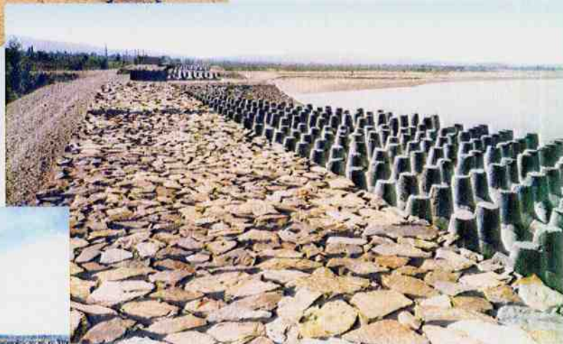
蔡家河口弯道险工工程
