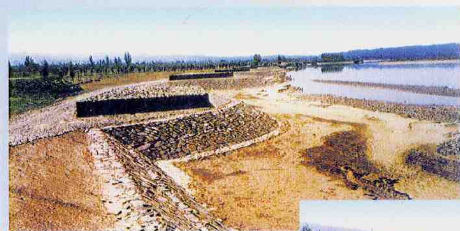
细腰子埝弯道险工工程
