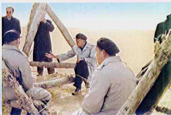
绑扎好的木架四面体
