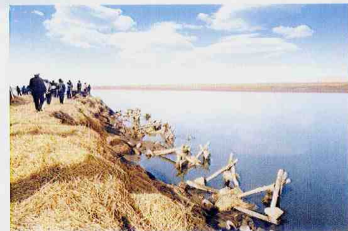
永宁东升黄河塌岸处投放的木架附重四面体
