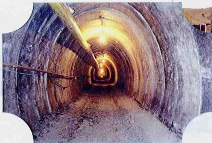
盐环定扬水石山子隧洞
