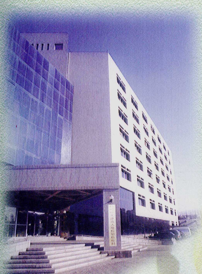
天津出入境检验检疫局办公大楼
