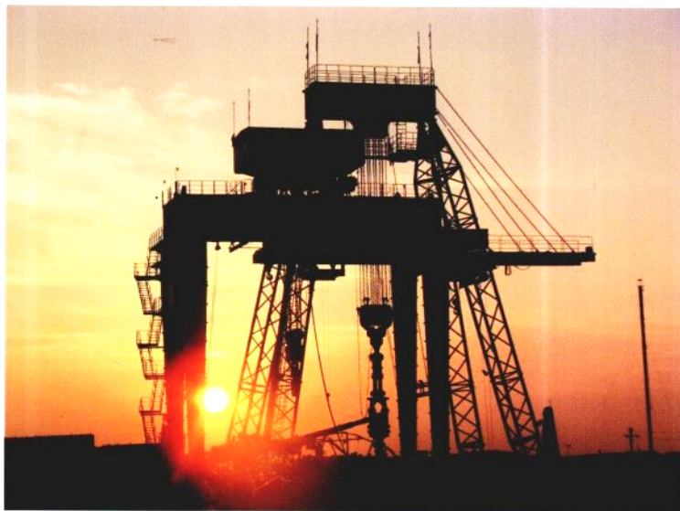
建设中的板集煤矿
