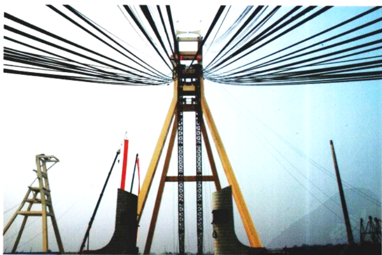
口孜东矿主井架设
