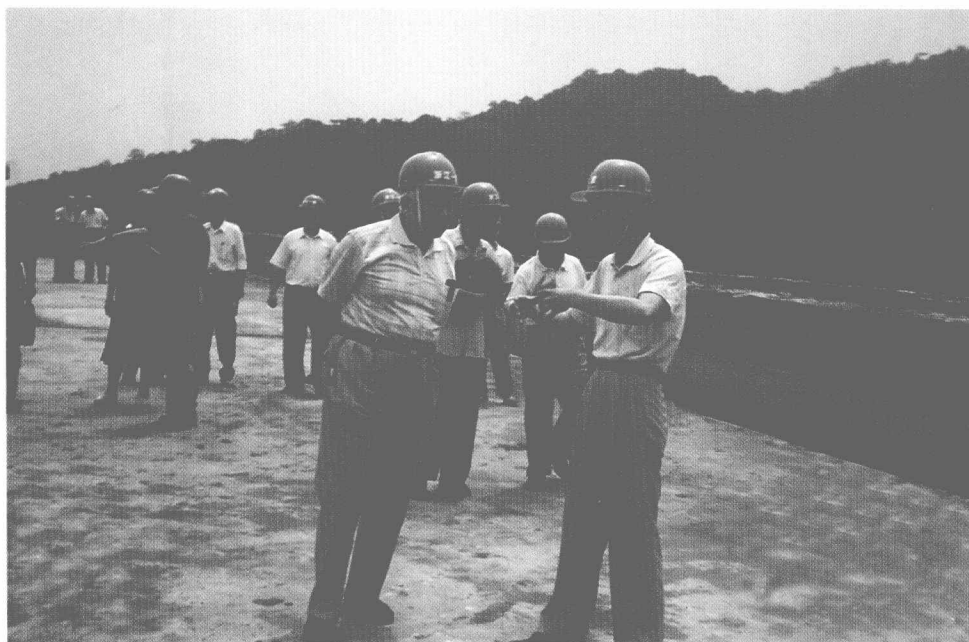
省领导现场视察施工中的浙江图书馆新馆工地
