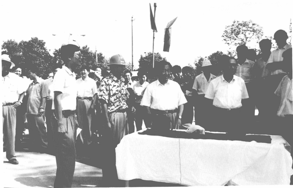
省领导拉响新馆土石方工程第一炮
