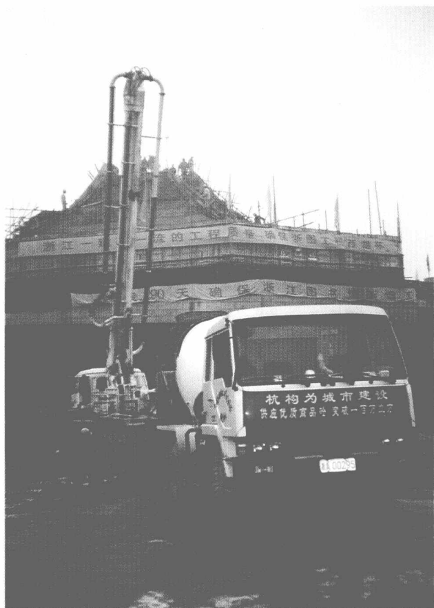
施工中的浙江图书馆新馆工程
