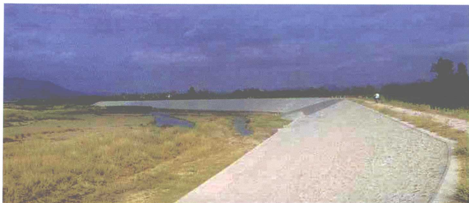
望楼河防洪工程
