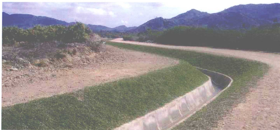
水利灌溉配套工程
