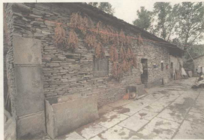
厢房在堂屋两侧，为暗间，分前后两间。长辈房居右，前为火铺房，后为卧室；晚辈房居左，前为灶台、厨房，后为卧室。
