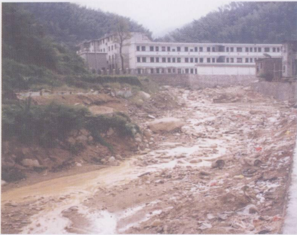
湖南郴州南溪乡小学前山洪沟（张平仓摄）
