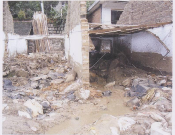
陕西宁陕县城被山洪冲毁的房屋（胡维忠摄）
