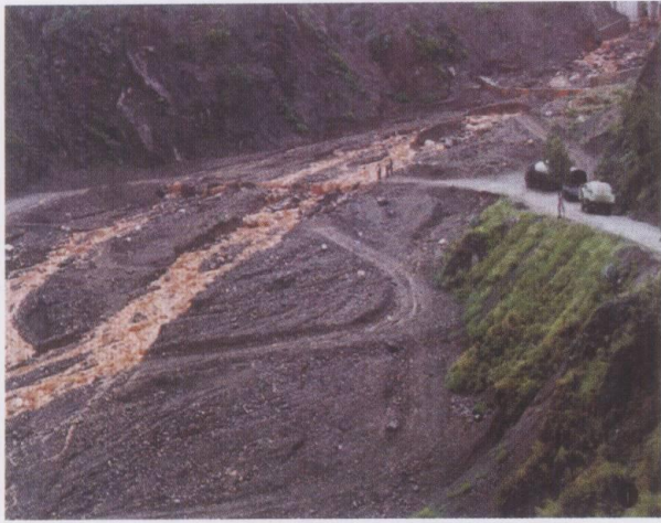
云南东川老干沟山洪泥石流（李德基摄）
