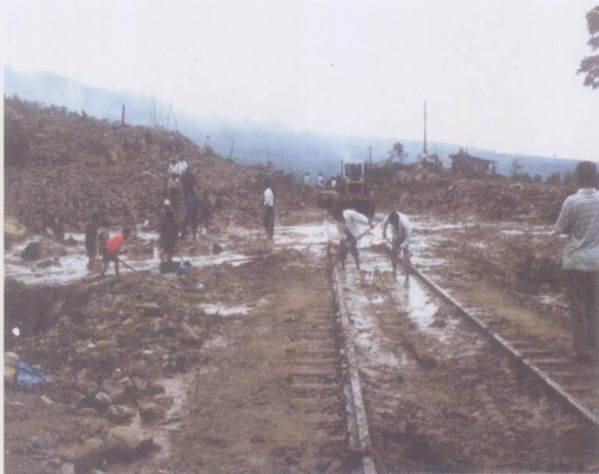
遭泥石流危害的成昆铁路（谢洪摄）
