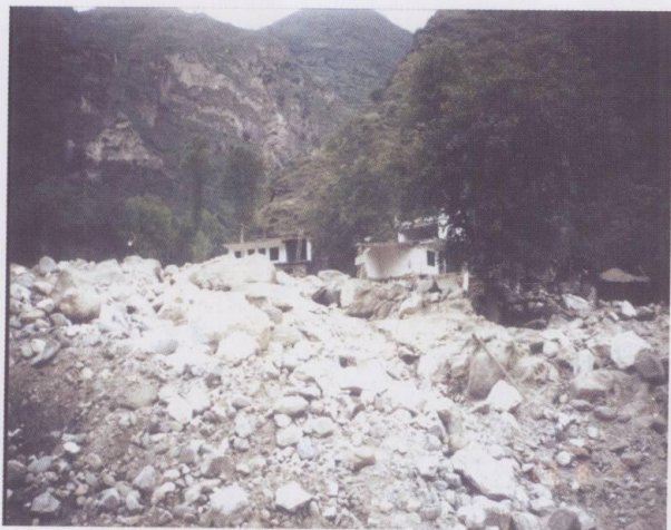
四川丹巴鹅狼沟被山洪泥石流沟 冲毁的民宅（刘希林摄）
