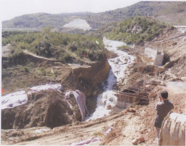
陕西铜黄被山洪冲毁的高速公路（胡维忠摄）
