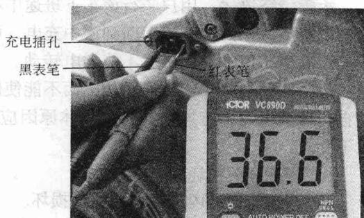
图 1-4 电动自行车充电插孔处电源电压的测量
