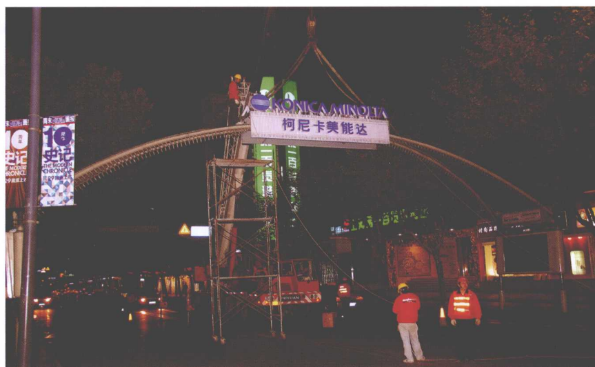
淮海路拆除跨街广告行动
