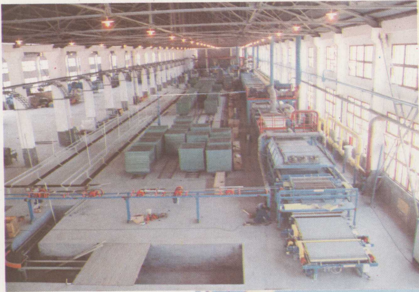
◀ 通城县彩釉砖厂 自动化生产车间
