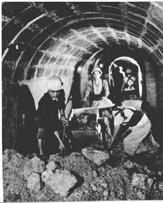
柳州船舶修理厂 广大民兵遵照毛主席 关于“深挖洞”的指 示，坚持常年施工， 深挖坑道，修筑地下 长城，积极加强战备。
