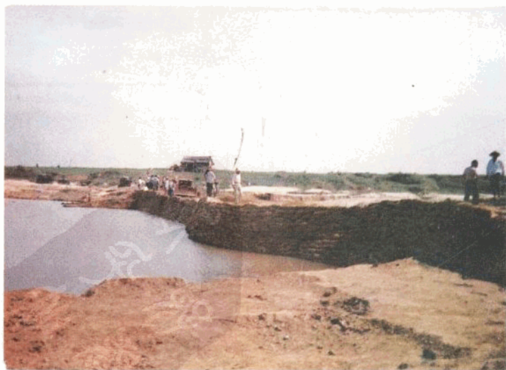
河道乱采滥挖造成堤坝决口的堵复现场
