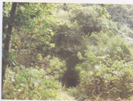
机场油库山洞现状
