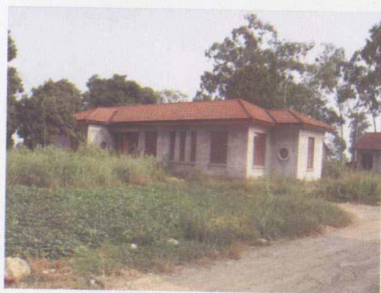
机场营房现状
