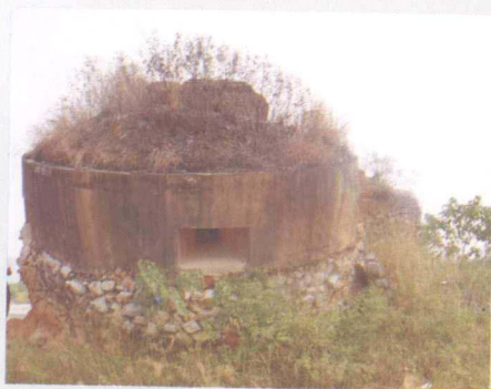
机场碉堡现状
