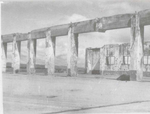
烧毁后的柳州机场设施
