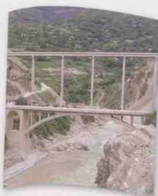
木里县安定桥
