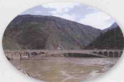
进入木里第一桥—小金河大桥
