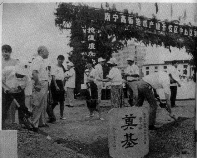
南宁高新技术产业开发区 区中心区破土动工
