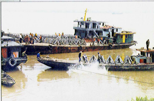
■ 引进推广新技术“四面六边透水框架”群抛投现场
