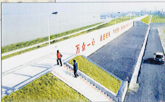
■ 九江城防堤1998年溃口段重建后新貌
