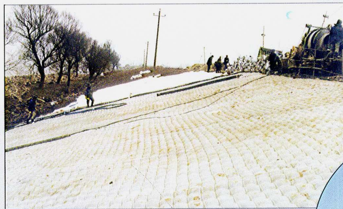
■ 九江长江大堤加固采用混凝土模袋护坡
