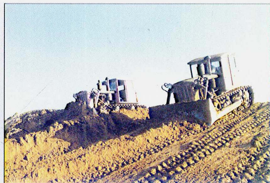
■ 水利冬修机械化施工
